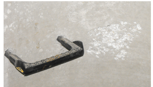
Inspeccione y prepare la superficie
