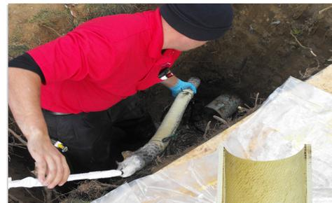
O PipePatch de Cotovelo se conforma exatamente ao formato original da tubulação.
